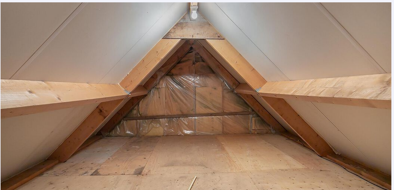
Garage met bergzolder.
