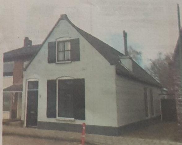
Antoniusstraat 39, een gecementeerde zijgevel in blokvorm met een kleurtje.
